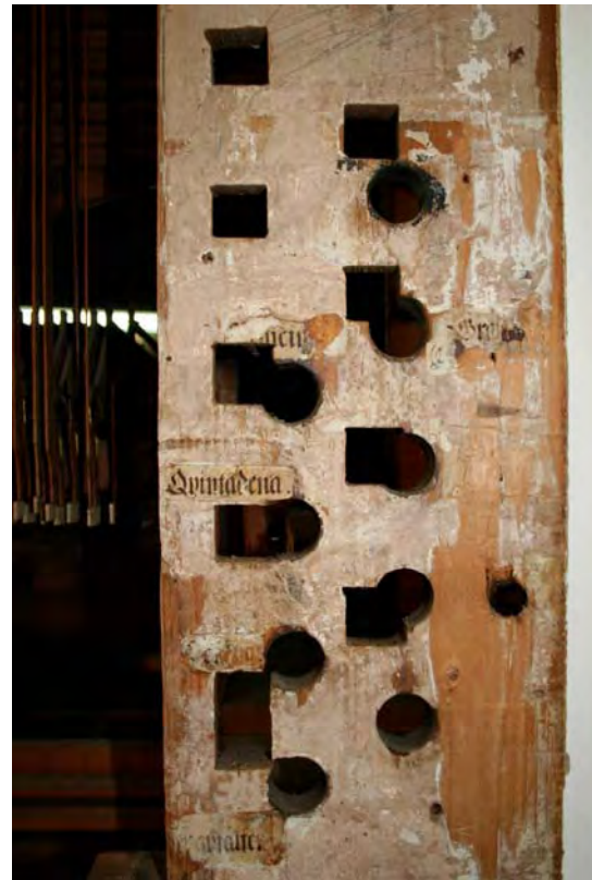
Abb. 004/005 Originale Registerstaffeleien rechts und links nach Abnahme der von Trampeli 1803 angefügten Spielschrankverkleidung Juli 2006
