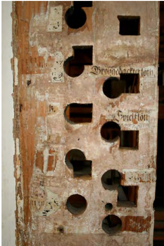
Abb. 004/005 Originale Registerstaffeleien rechts und links nach Abnahme der von Trampeli 1803 angefügten Spielschrankverkleidung Juli 2006
