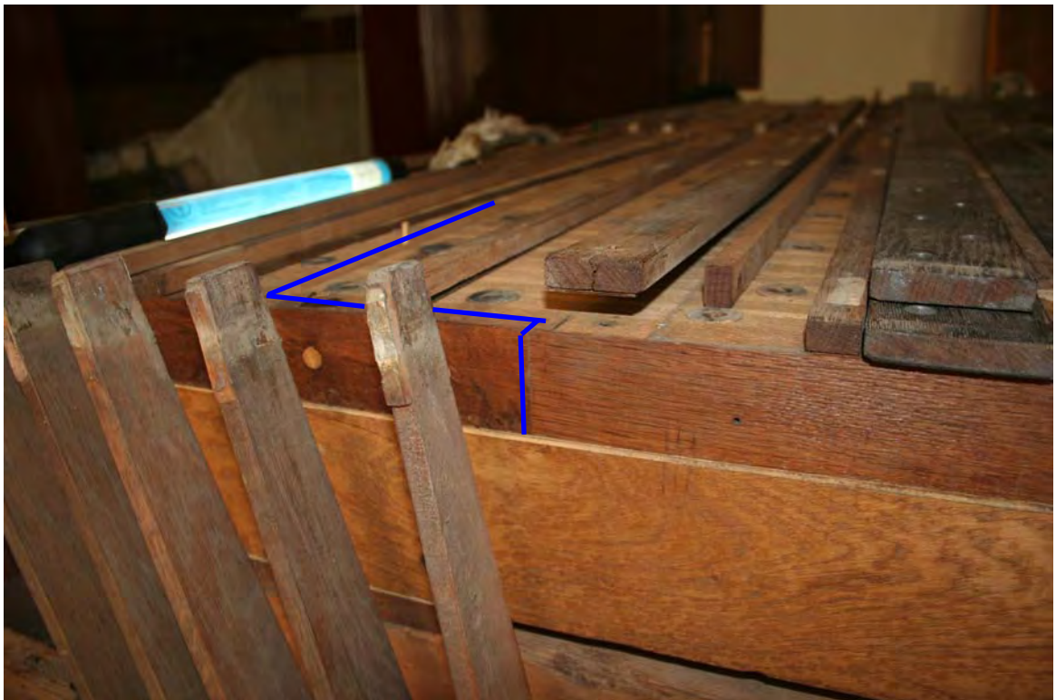
Abb. 040 Manuallade Ansicht von links mit sichtbarer Erweiterung (Juli 2006)
